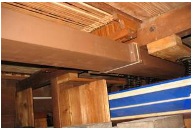
Le nouveau porte-vent passe sous la mécanique du G.O. et au dessus de l'antiscousse
