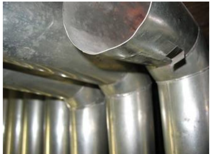
Les pavillons des basses du Basson 16 traversent le plancher d'accord des fonds du G.O.. La suite est soudée pour passer sous le sommier des aigus de pédale
