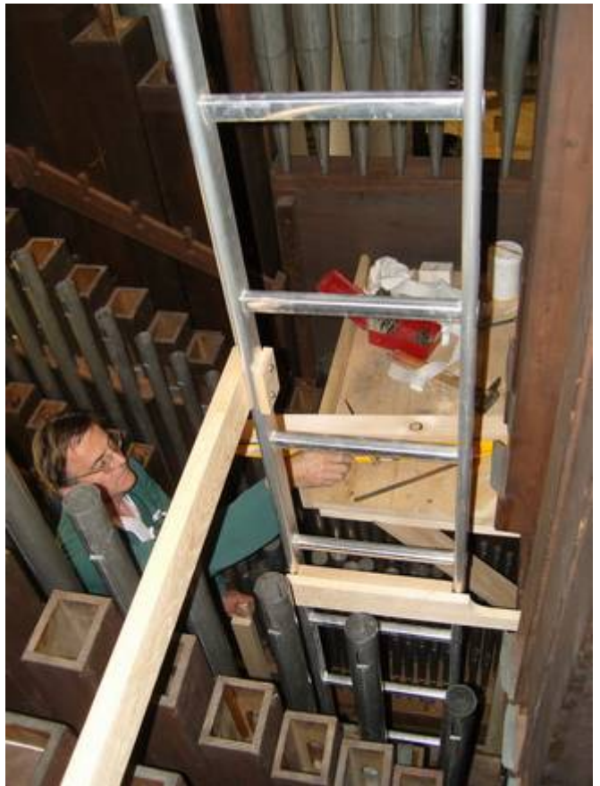
Nous avons ajouté des marchepieds neufs pour faciliter l'accès aux différentes parties de l'orgue; Ici, un marche pied et une échelle fixe verticale donnent accès au fonds du G.O.
