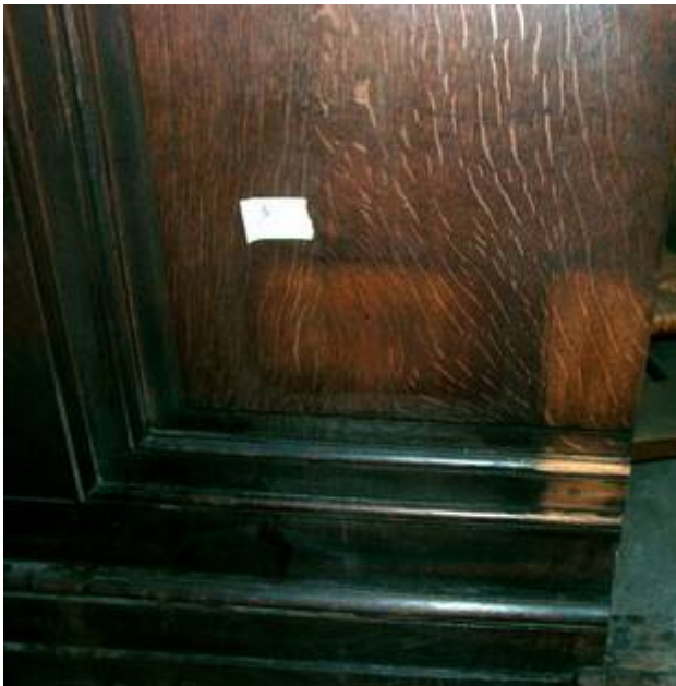
Les premiers essais de nettoyage tranchent singulièrement, surtout au niveau des plinthes
