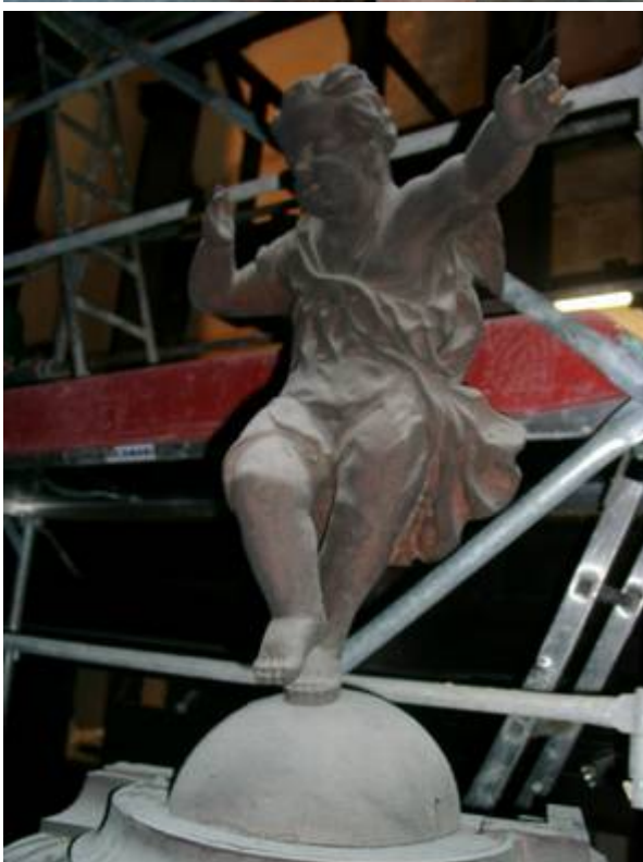
Quelques photos permettant de mesurer l'efficacité d'un dépoussiérage en profondeur (brosse, aspirateur, soufflette, éponge et eau chaude) avant l'application du verni choisi
