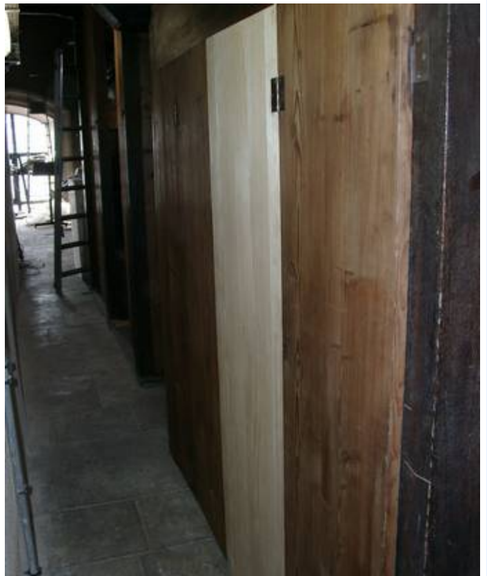
Le couloir derrière la soufflerie et la Barker, après remise en place des panneaux de sapin et fournitures des portes disparues
